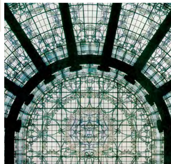
Il velario di copertura dell'Aula della Camera, opera liberty di Giovanni Beltrami.
